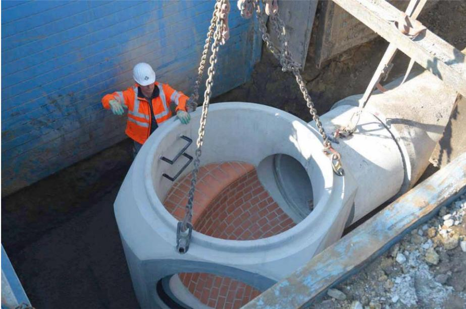
Herablassen von FBS-Schachtunterteil in die Baugrube. (Foto: FBS)
