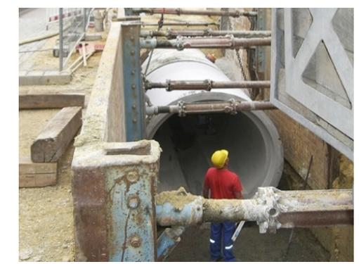
Verlegung eines Stahlbetonrohres in offener Bauweise
