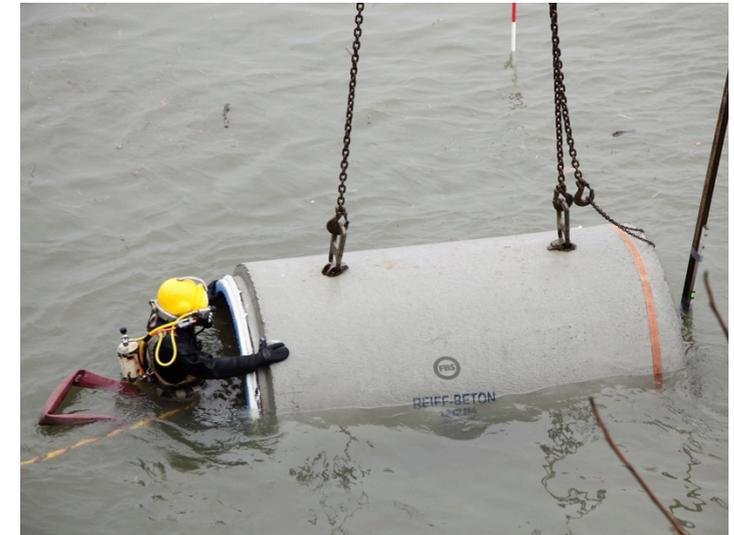
Verlegung eines Stahlbetonrohres im Rhein als Teil eines Auslaufkanals
