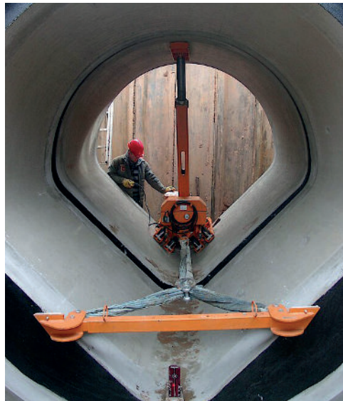
Abbildung 41: Rohrzuggerät (WIMAG)
