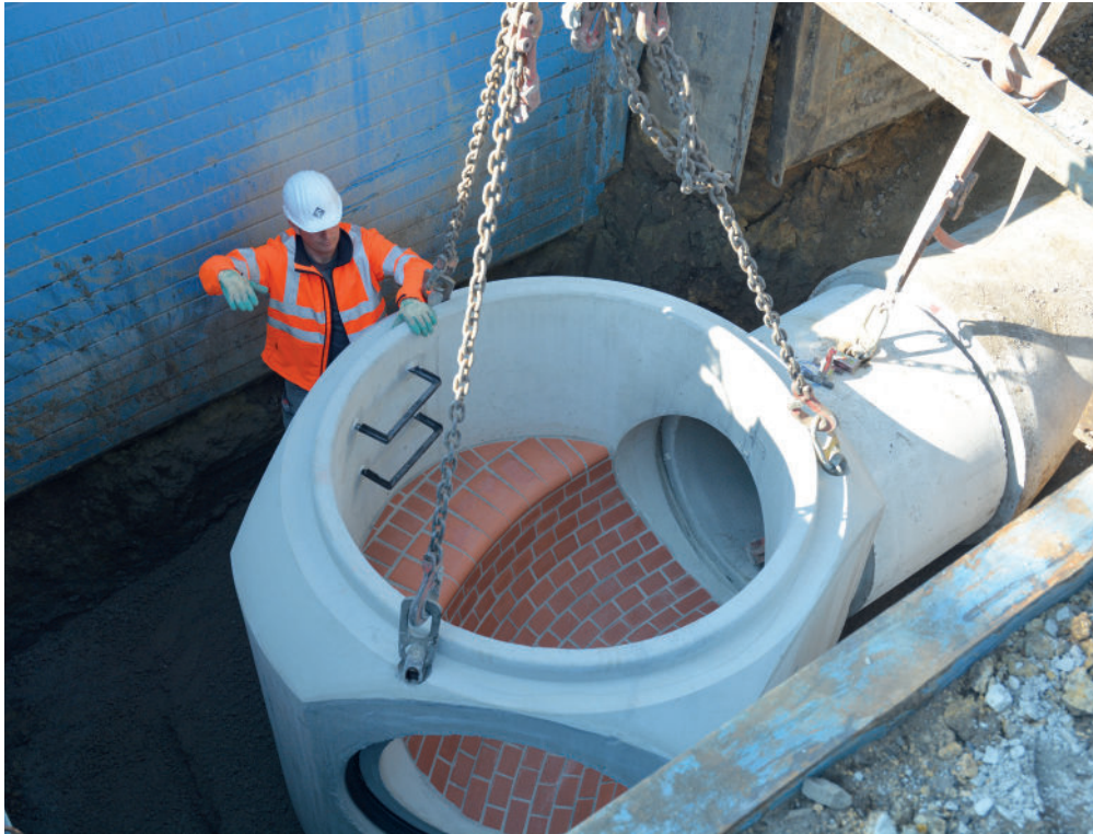
Abbildung 66: Einbau FBS-Schachtunterteil
