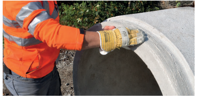
Abbildung 37: Auftragen des Gleitmittels auf dem Spitzende
