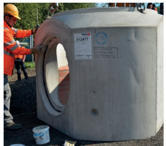
Abbildung 65: Gleitmittelauftrag am Rohranschluss (Schachtfutter)
