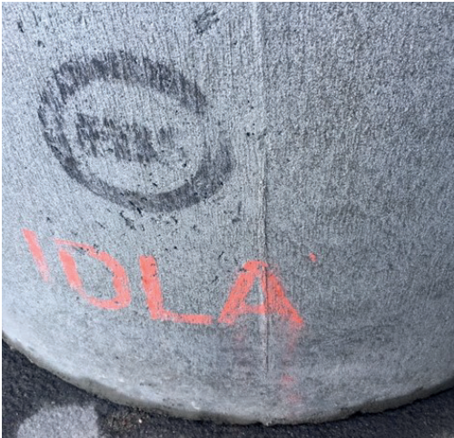
Abbildung 68: Schachtringmarkierung als Erhöhung außen
