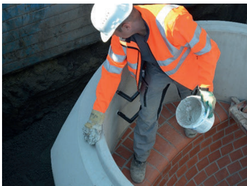
Abbildung 70: Gleitmittelauftrag Schachtbauerteile
