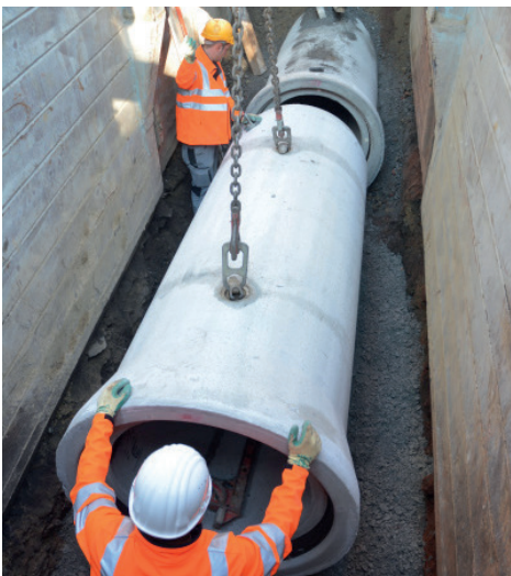
Abbildung 39: FBS-Rohr frei am Hebegerät hängend (FBS)
