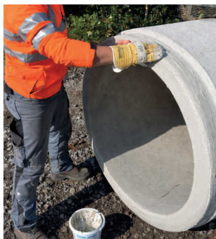
Abbildung 64: Gleitmittelauftrag auf dem Spitzende
