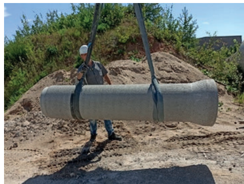
Abbildung 9: Seilschlaufen
