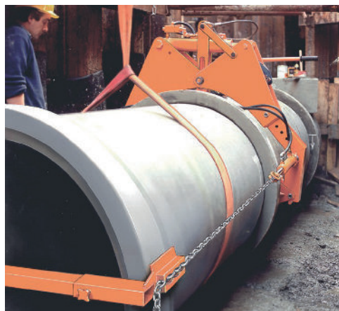
Abbildung 43: Rohrzuggerät (WIMAG)
