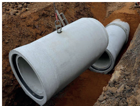
Abbildung 6: Rohr mit Kugelkopfkanker (Berding Beton)
