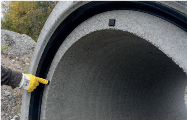
Abbildung 38: Anbringung Stoßfugenbegrenzer auf Muffenspiegel
