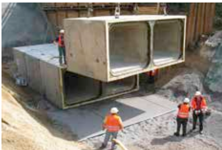
Bild 2.29: FBS-Stahlbetonrohr mit Rechteckquerschnitt (Beispiel: Doppelkanal)
