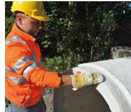
Bild 6.21: Auftragen des Gleitmittels auf dem Spitzende
