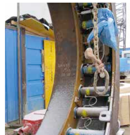
Bild 7.4: Teilansicht einer Zwischenpressstation
