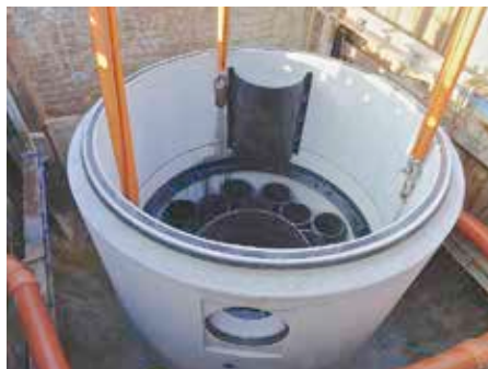
Bild 5.23: Filter- und Sedimentationsschacht, FBS-Schachtbauwerk rund
