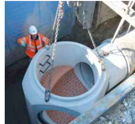
Bild 6.36: Schachteinbau
