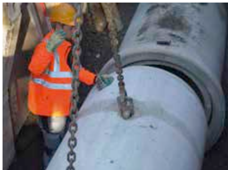
Bild 5.32: Zusammenziehen von FBS-Rohren
