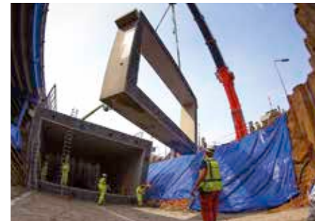
Bild 5.28: Radwegunterführung mit Spannkälen, FBS-Stahlbetonrohr mit Rechteckquerschnitt
