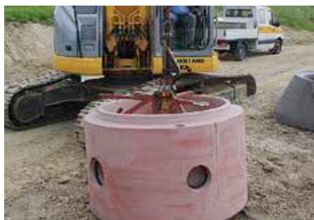
Bild 5.13: FBS-Schachtunterteile, System „Perfect“ mit monolithischem Gerinne
