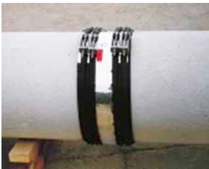
Bild 6.35: Manschettenverbindung
