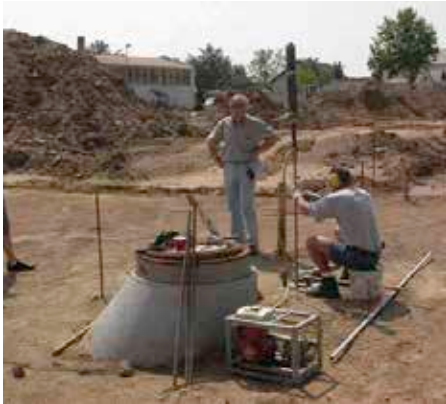
Bild 6.30: Prüfen der Verdichtung durch Rammsondierung
