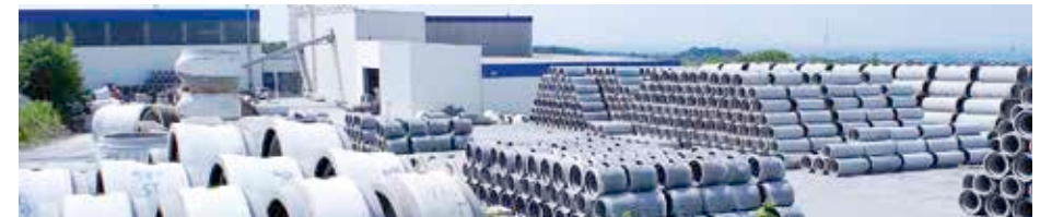
Bild 3.2: Blick auf ein Betonrohrwerk
