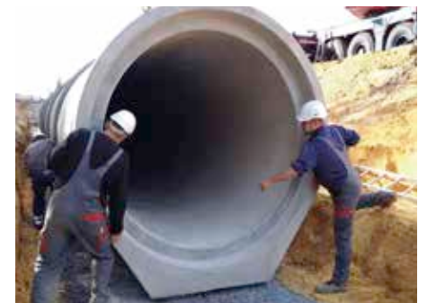
Bild 5.8: FBS-Stahlbetonrohr mit Fuß
