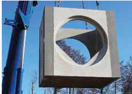
Bild 5.21: Einsteigschacht für Stauraumkanal, FBS-Schachtbauwerk aus Stahlbetonfertigteilen
