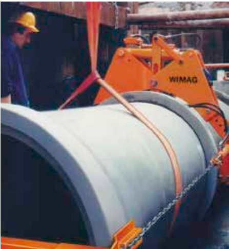
Bild 6.23: Zusammenziehen der Rohre mit Rohrzuggerät
