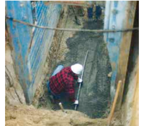
Bild 6.27: Herstellen einer Betonbettung
