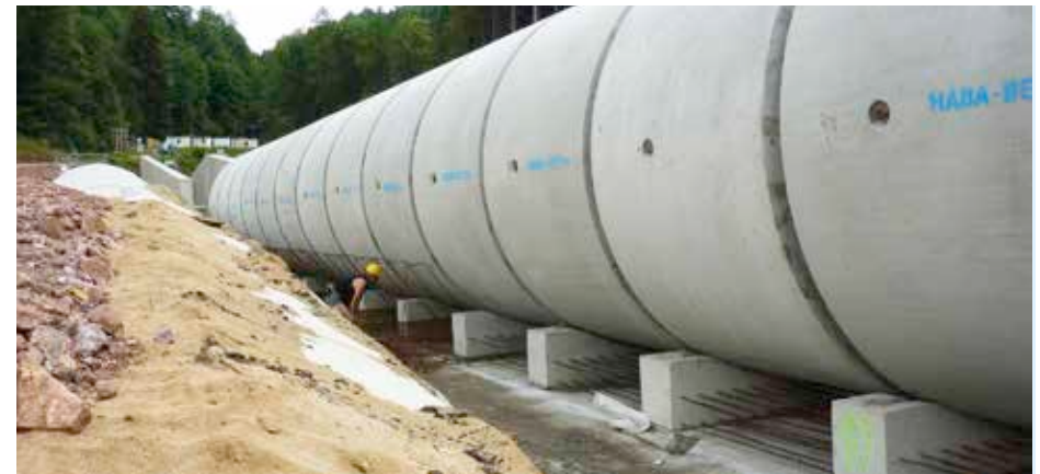
Bild 5.36: FBS-Stahlbetonrohre auf Auflagerbalken
