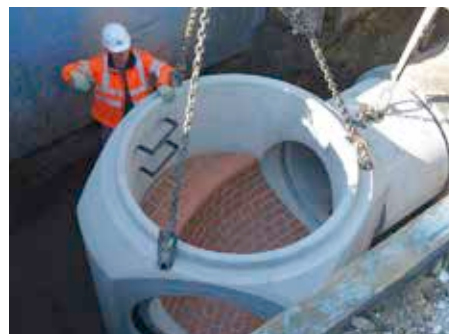
Bild 5.33: Herablassen des FBS-Schachtes
