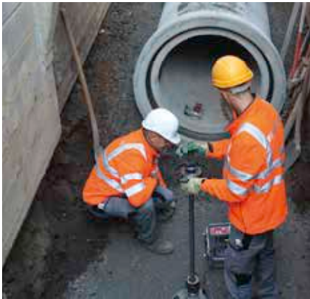
Bild 2.2: Einbau eines FBS-Betonrohres
