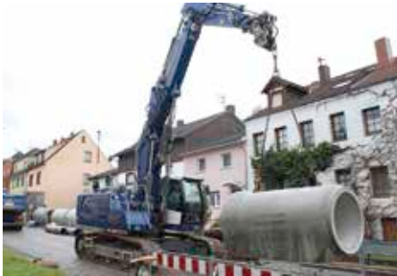
Bild 6.6: Transport- und Einbauanker, FBS-Rohr
