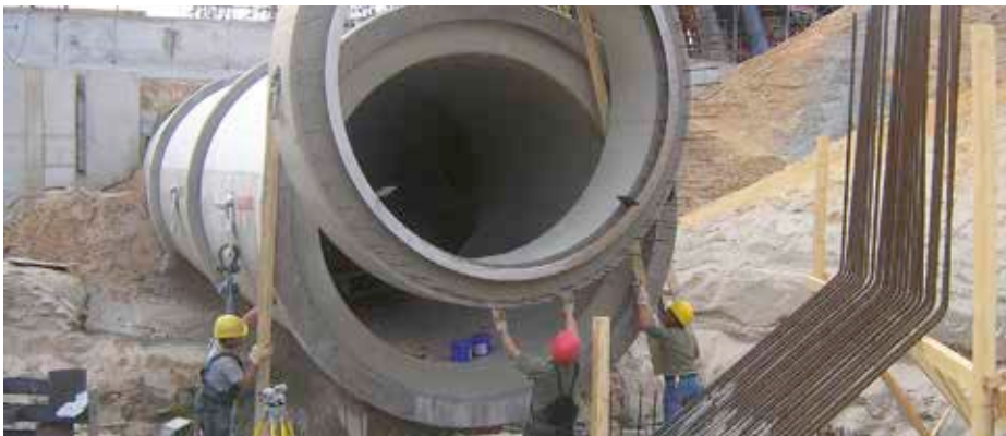
Bild 5.3: Kühlwasserleitung Kraftwerk, FBS-Stahlbetondruckrohr mit Kreisquerschnitt
