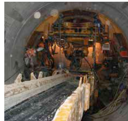
Bild 7.7: Materialabbau an der Ortsbrust
