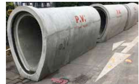
Bild 2.17: FBS-Betonrohr mit Eiquerschnitt
