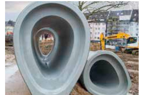
Bild 5.6: FBS-Betonrohre mit Eiquerschnitt
