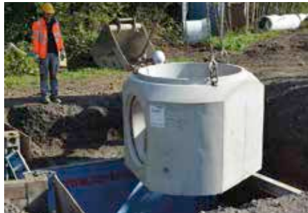
Bild 6.7: Transport- und Verlegeanker, FBS-Schachtunterteil
