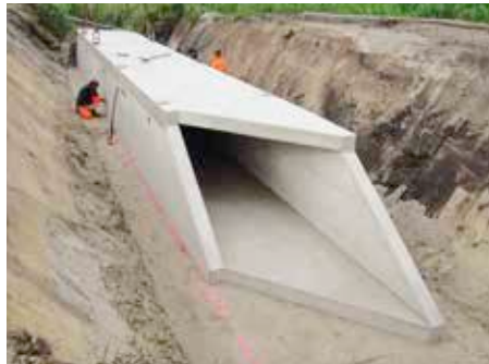
Bild 5.31: Gewässerdurchlass, FBS-Stahlbetonrohr mit Rechteckquerschnitt
