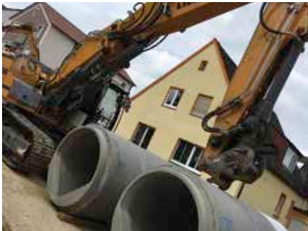
Bild 5.9: FBS-Stahlbetonrohr mit Drachenquerschnitt
