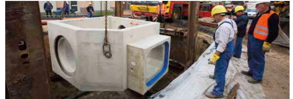
Bild 2.58: Beispiel eines Vereinigungsbauwerkes in Kompaktbauweise
