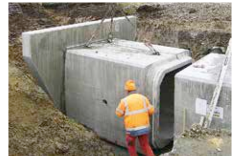
Bild 5.29: Gewässerdurchlass mit Stirnwand, FBS-Stahlbetonrohr mit Rechteckquerschnitt
