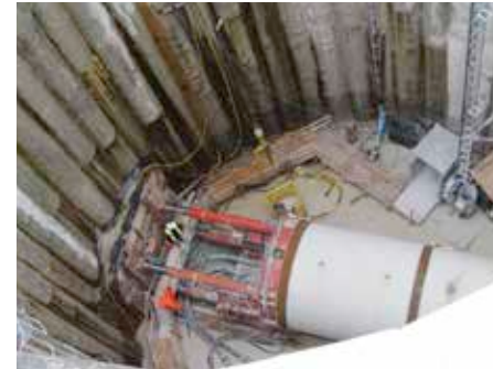
Bild 5.34: Blick in den Startschacht, FBS-Stahlbetonvortriebsrohr
