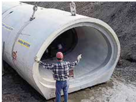
Bild 5.10: FBS-Stahlbetonrohr mit Maulquerschnitt
