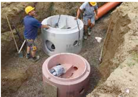
Bild 5.13: FBS-Schachtunterteile, System „Perfect“ mit monolithischem Gerinne
