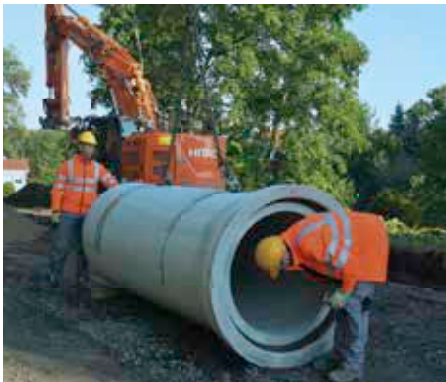
Bild 6.18: Kontrolle des Muffenbereiches vor dem Einbau
