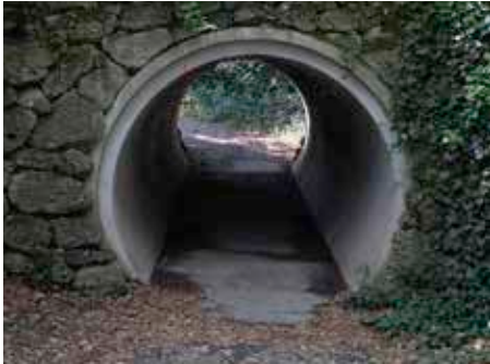
Bild 5.30: Fuß- und Radwegunterführung, FBS-Stahlbetonrohr mit Kreisquerschnitt
