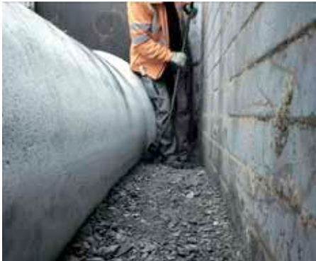
Bild 6.24: Verdichtung der Rohrzwickel von Hand
