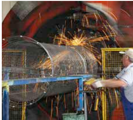
Bild 2.19: Herstellung eines Bewehrungskorbs
