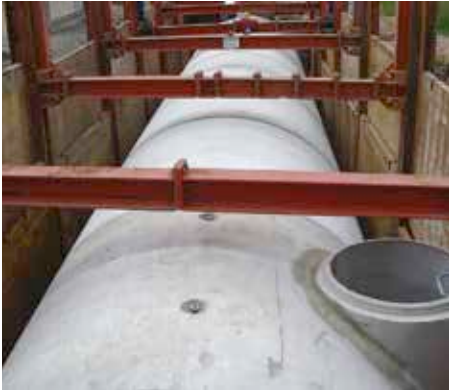
Bild 2.49: FBS-Tangentialschacht auf der Baustelle
