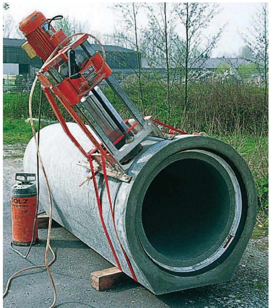
**Bild 9:** Herstellung einer Anschlussöffnung mittels Kernbohrung, Bild FBS
