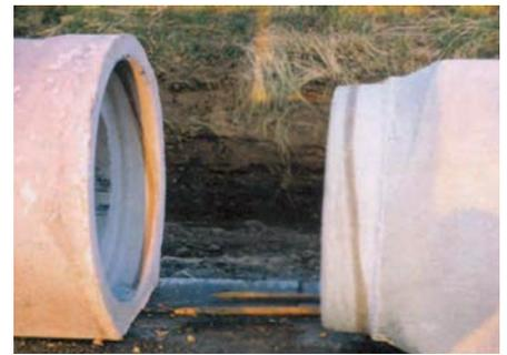
**Bild 2+3:** Rollringdichtung auf einem Spitzende vor dem Zusammenführen der Rohre; Abdruck einer fehlerhaft montierten Rollringdichtung, Bilder DS Dichtungstechnik
