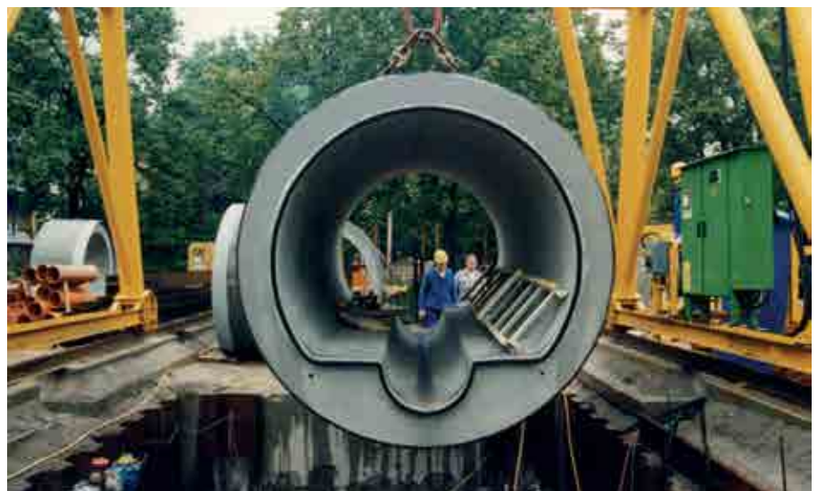
Bild 1: Rohre mit hydraulisch günstigen Abflußquerschnitten bei stark variierenden Abflussmengen
