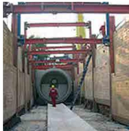
**Bild 1:** Stahlbetonrohre bieten ein Plus gegen Auftrieb auch bei großen Nennweiten und geringen Überdeckungshöhen (Emunds & Staudinger GmbH, Hückelhoven)
