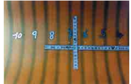
Bild 6: Löcher in einem profilierten PE-HD-Rohr – Prüfkart „Deblocking“ [1]
