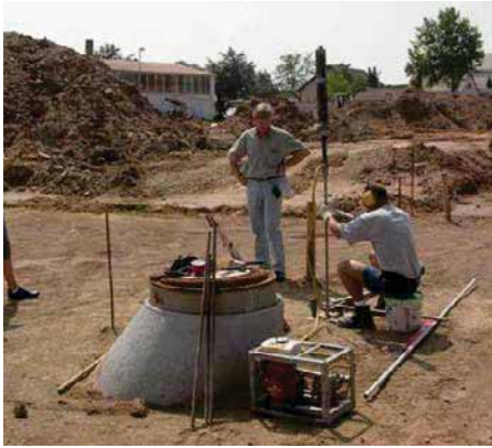
Bild 6.30: Prüfen der Verdichtung durch Rammsondierung
