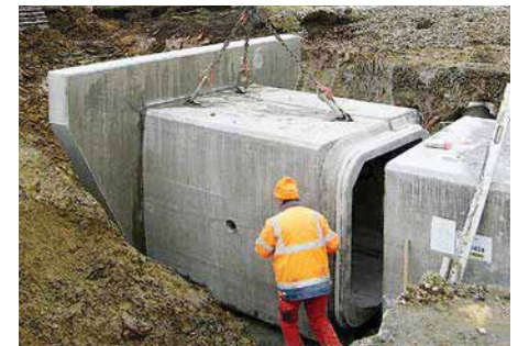
Bild 5.29: Gewässerdurchlass mit Stirnwand, FBS-Stahlbetonrohr mit Rechteckquerschnitt
