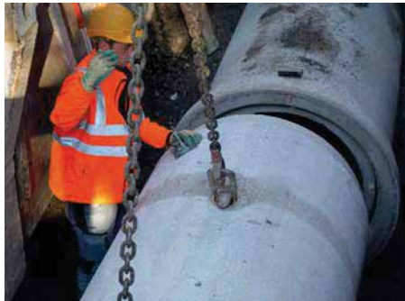
Bild 5.32: Zusammenziehen von FBS-Rohren
