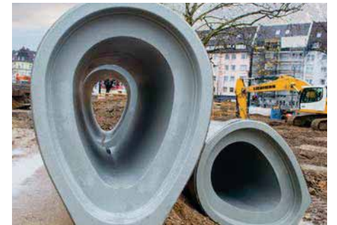
Bild 5.6: FBS-Betonrohre mit Eiquerschnitt
