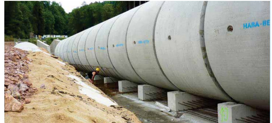
Bild 5.36: FBS-Stahlbetonrohre auf Auflagerbalken
