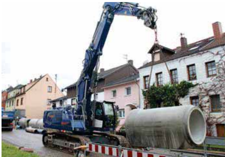
Bild 6.6: Transport- und Einbauanker, FBS-Rohr
