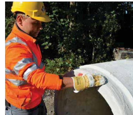
Bild 6.21: Auftragen des Gleitmittels auf dem Spitzende
