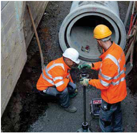
Bild 2.2: Einbau eines FBS-Betonrohres
