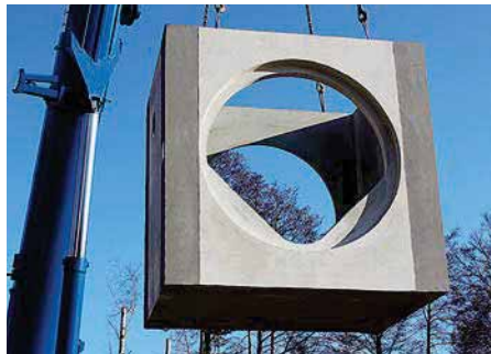
Bild 5.21: Einsteigschacht für Stauraumkanal, FBS-Schachtbauwerk aus Stahlbetonfertigteilen
