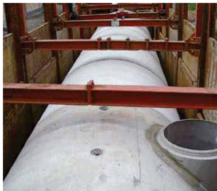
Bild 2.49: FBS-Tangentialschacht auf der Baustelle
