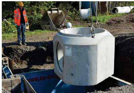
Bild 6.7: Transport- und Verlegeanker, FBS-Schachtunterteil
