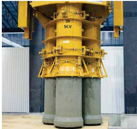
Bild 3.9: Ziehen der Außenschalung
