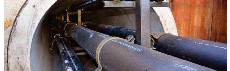
Bild 5.4: Schutzrohrleitung – FBS-Stahlbetonvortriebsrohr
