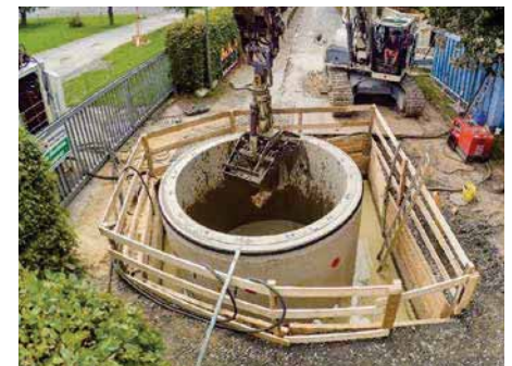
Bild 5.17: Absenkschacht, FBS-Stahlbetonrohr mit Kreisquerschnitt
