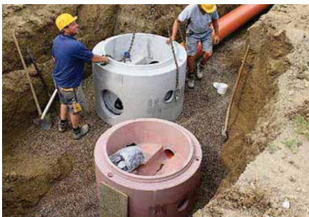
Bild 5.13: FBS-Schachtunterteile, System „Perfect“ mit monolithischem Gerinne
