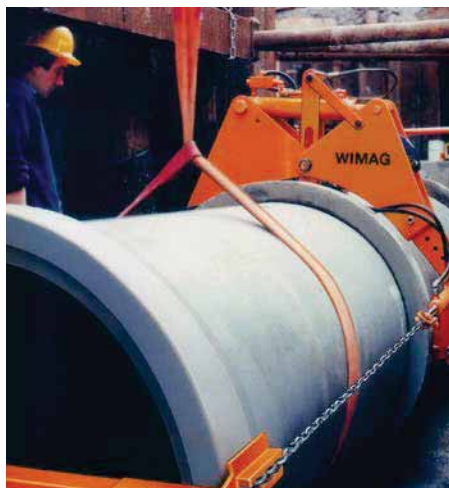
Bild 6.23: Zusammenziehen der Rohre mit Rohrzuggerät
