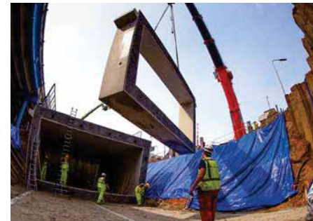
Bild 5.28: Radwegunterführung mit Spannkanälen, FBS-Stahlbetonrohr mit Rechteckquerschnitt
