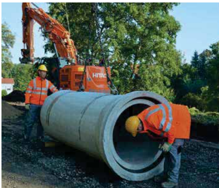
Bild 6.18: Kontrolle des Muffenbereiches vor dem Einbau
