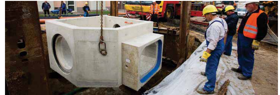
Bild 2.58: Beispiel eines Vereinigungsbauwerkes in Kompaktbauweise
