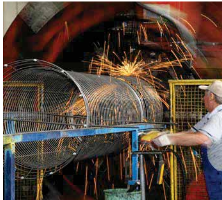
Bild 2.19: Herstellung eines Bewehrungskorbs
