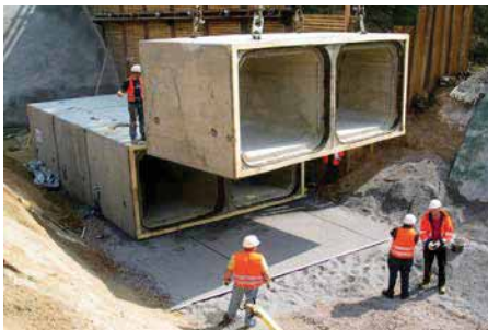
Bild 2.29: FBS-Stahlbetonrohr mit Rechteckquerschnitt (Beispiel: Doppelkanal)
