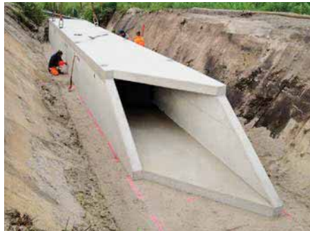
Bild 5.31: Gewässerdurchlass, FBS-Stahlbetonrohr mit Rechteckquerschnitt
