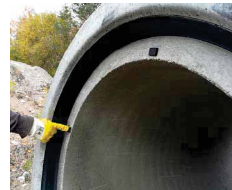
Bild 6.22: Anbringen Stoßfugenbegrenzer
