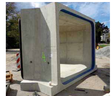
Bild 2.25: FBS-Stahlbetonrohr mit Rechteckquerschnitt
