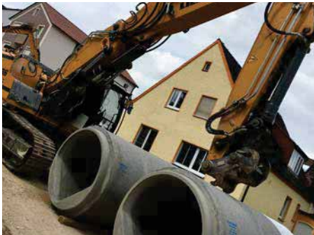
Bild 5.9: FBS-Stahlbetonrohr mit Drachenquerschnitt
