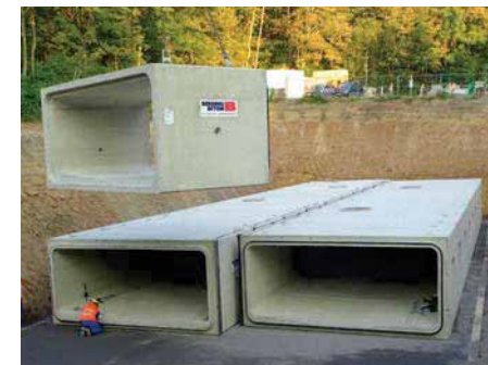
Bild 5.18: Regenklärbecken, FBS-Stahlbetonrohr mit Rechteckquerschnitt
