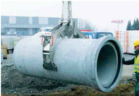
Bild 6.4: Rohrgreifer
