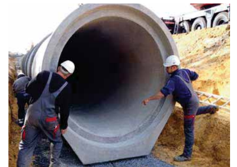
Bild 5.8: FBS-Stahlbetonrohr mit Fuß
