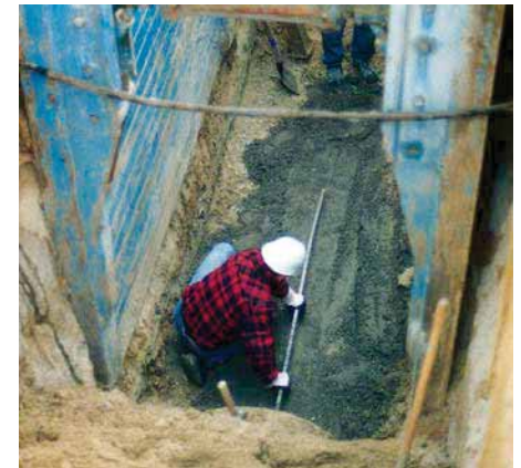
Bild 6.27: Herstellen einer Betonbettung
