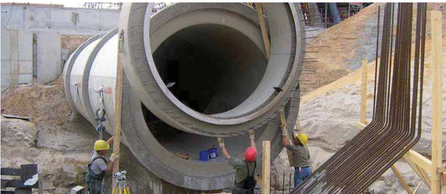
Bild 5.3: Kühlwasserleitung Kraftwerk, FBS-Stahlbetondruckrohr mit Kreisquerschnitt
