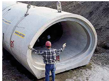
Bild 5.10: FBS-Stahlbetonrohr mit Maulquerschnitt
