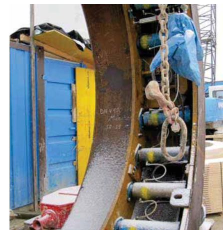
Bild 7.4: Teilsicht einer Zwischenpressstation
