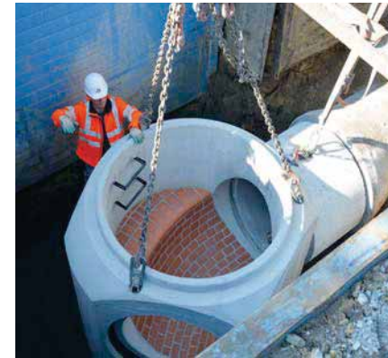
Bild 6.36: Schachteinbau
