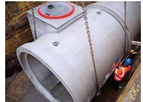
Bild 5.15: FBS-Tangentialschacht
