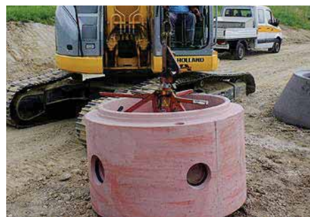
Bild 5.13: FBS-Schachtunterteile, System „Perfect“ mit monolithischem Gerinne
