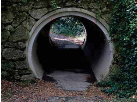
Bild 5.30: Fuß- und Radwegunterführung, FBS-Stahlbetonrohr mit Kreisquerschnitt
