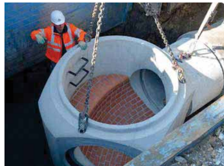
Bild 5.33: Herablassen des FBS-Schachtes
