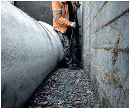
Bild 6.24: Verdichtung der Rohrzwickel von Hand
