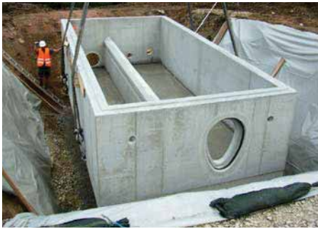
Bild 5.20: Regenüberlaufbauwerk, FBS-Schachtbauwerk aus Stahlbetonfertigteilen
