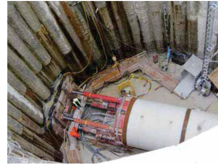
Bild 5.34: Blick in den Startschacht, FBS-Stahlbetonvortriebsrohr
