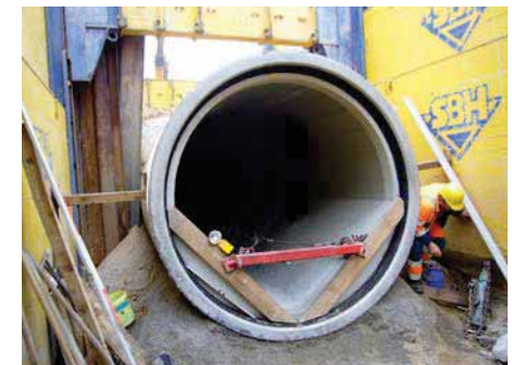
Bild 5.19: Stauraumkanal, FBS-Stahlbetonrohr mit Kreisquerschnitt
