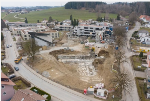
Das frühere Seniorenzentrum von St. Vinzenz wurde abgerissen. Rund 15.000 Tonnen Betonbruch wurden wiederverwendet.
