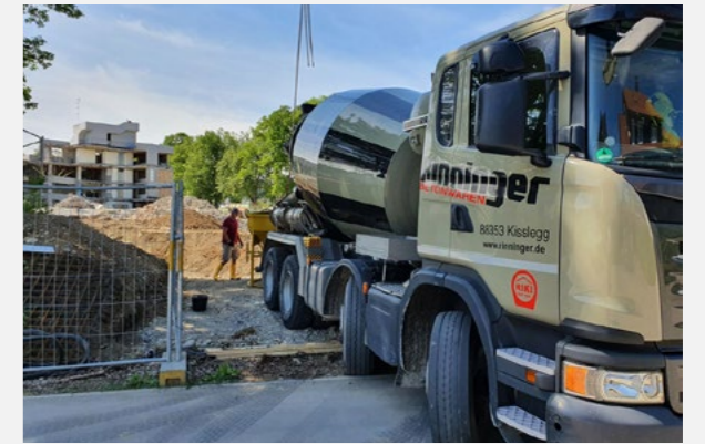
Rund 9.000 m 3 Recyclingbeton lieferte das Betonwerk Rinninger auf die Baustelle in Wangen.
